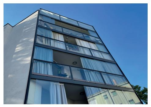
Abb. 31: Symbolbild architektonische Maßnahme: Gedämmte und verglaste Loggia
